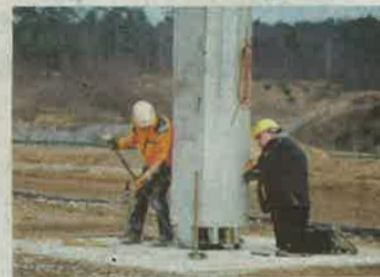
Arbeiter beim Verankern der Stützen.
