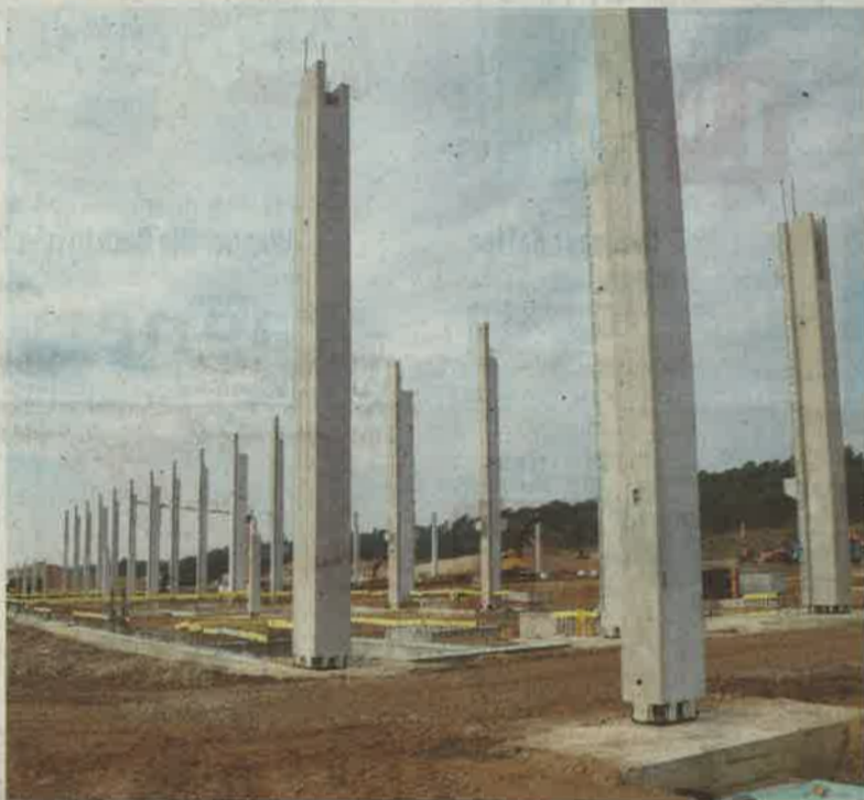
Wie bleiche Knochen eines Saurierskeletts: die Betonstützen des künftigen Verwaltungstraktes.
