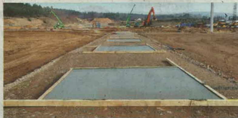
Die Tiefengründung war in dem sandigen, schluffigen Boden ein schwieriges Unterfangen. Dafür wurde viel Boden abgetragen. Das Material lagert im Hintergrund.
