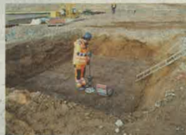
Techniker bei der Bodendichtemessung.
