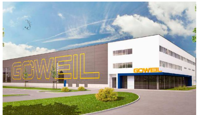
Den größten Teil des neuen Göweil-Firmenstandortes werden eine Lackieranlage sowie eine Montagehalle einnehmen.
