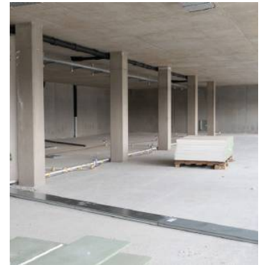
Der Innenausbau der Büros geht ebenfalls voran.
