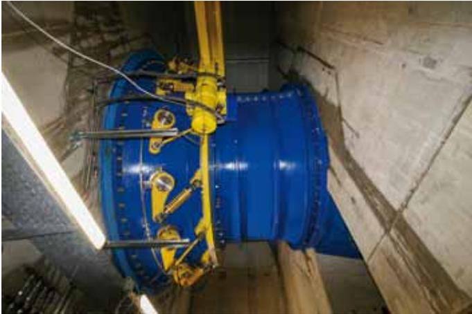
zwei identisch konstruierte Kaplan-Turbinen in Bulb-Ausführung
